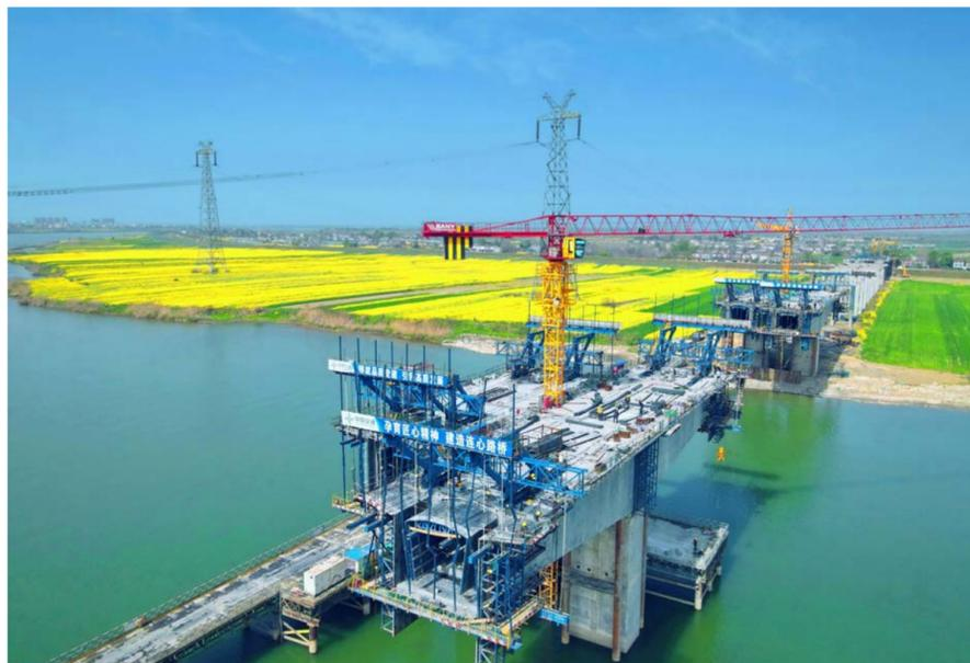
提速快上,追赶春天的步伐。3月31日,348国道沙洋汉江公路二桥工程19号右幅连续梁11号块顺利浇筑完成,项目部克服疫情、汛期等困难,化解资金、材料供应矛盾,并结合项目实际优化工艺流程后将功效提升20%,比预计工期提前9天。目前该项目已经全面进入现浇连续箱梁施工,计划在年底完成全部桥梁合拢。(张迪 贺新尊)
