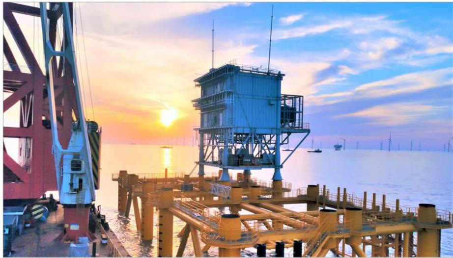
4月8日,新能源公司承建的江苏如东H15号风电场分体式升压站上部组块正式吊装完成。这是公司首次实施分体式海上升压站组块吊装。(雷俊卿)
