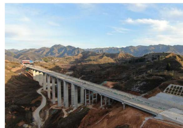
11月11日,由交建分公司承建的菜卢高速公路项目卢氏南互通立交2号主线桥预制梁架桥机顺利架桥,标志着项目部桥梁工程施工开始转入上部结构施工阶段。该桥全长568.22米,共计14跨151根预制T梁。项目建成后,将成为带动豫西南地区经济发展的纽带,对支持贫困地区特色产业发展和脱贫攻坚工作具有积极的意义,是一条着力建设区域发展和脱贫致富的“康庄大道”。
