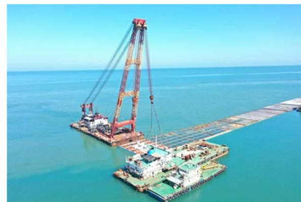
11月7日,由江苏分公司施工的海南炼化码头项目顺利完成全部沉箱安装任务。沉箱单个重达5700吨,是华南地区最大的防波堤沉箱。52件沉箱成“长龙”之姿盘踞于洋浦湾,标志着该项目完成施工难度最大、安全风险最高的分项工程。项目建成后,对保障国家能源安全、建设海南国家生态文明试验区具有重大意义。(葛春亭)
